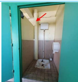
Matériaux : ZPSO-001 Prélèvement : Description : Conduits d'évacuation d'eau Localisation : Rez de chaussée - Sanitaires Résultat : Présence d'amiante
