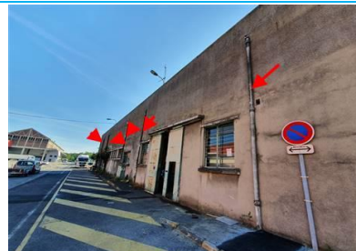
Matériaux : ZPSO-004 Prélèvement : Description : Conduits d'évacuation d'eau Localisation : Façades - Façades Résultat : Présence d'amiante
