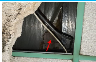
Matériaux : ZPSO-003 Prélèvement : Description : Plaques en fibres-ciment (y compris plaques « sous tuiles ») Localisation : Toiture - Toiture Résultat : Présence d'amiante
