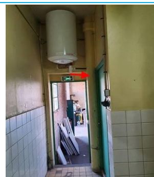
Matériaux : ZPSO-002 Prélèvement : Description : Conduits d'évacuation d'eau Localisation : Rez de chaussée - Sanitaires Résultat : Présence d'amiante
