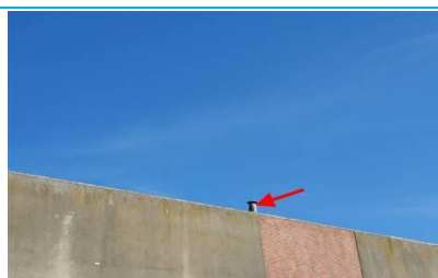
Matériaux : ZPSO-005 Prélèvement : Description : Conduits de cheminée Localisation : Toiture - Toiture Résultat : Présence d'amiante
